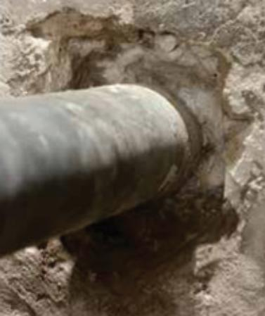
Разрушение конструкции вокруг трубы
