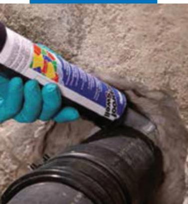
Нанесение Maperproof Swell вокруг трубы
