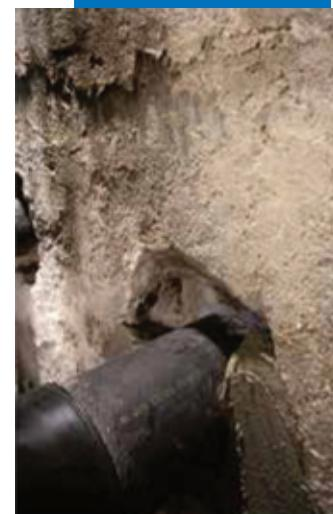
Заделка **Mapeproof Swell** с помощью материала из линейки **Maregrout**
