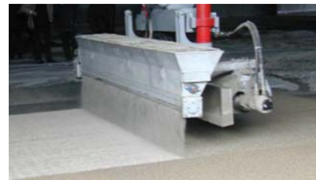
Механизированное нанесение Mapetop N AR6
