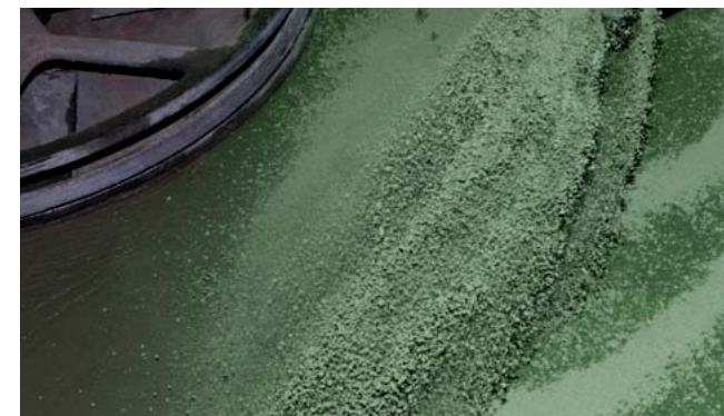
Нанесение Mapetop N AR6 вручную
