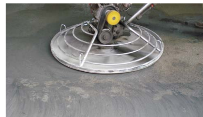
Затирка Mapetop N AR6 при помощи затирочной машины
