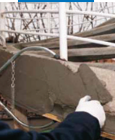
Нанесение MapegROUT 430 при помощи мастерка
