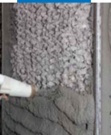
Нанесение MapegROUT 430 набрызгом
