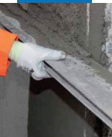
Выравнивание MapegROUT 430 при помощи правила
