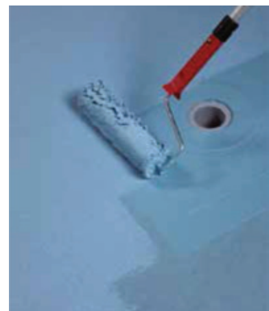
Нанесение валиком второго слоя Mapelastic AquaDefense
