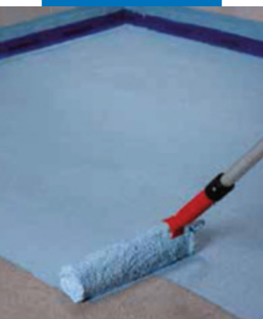
Нанесение первого слоя Mapelastic AquaDefense на стяжку
