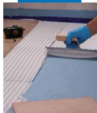
Приклеивание плитки на Mapelastic AquaDefense
