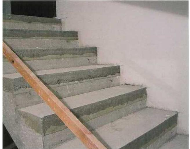
По своим свойствам PCI Novoment M3 plus пригоден также для выравнивания высоты бетонных ступенек.
