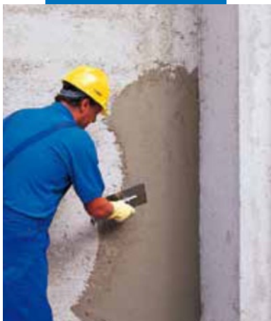
Нанесение шпателем
